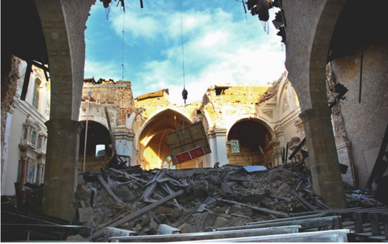
Fig. 19.24 The collapse of the dome of the Basilica of Santa Maria di Collemaggio in L'Aquila
